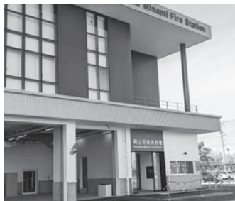
岡山南消防署移転
