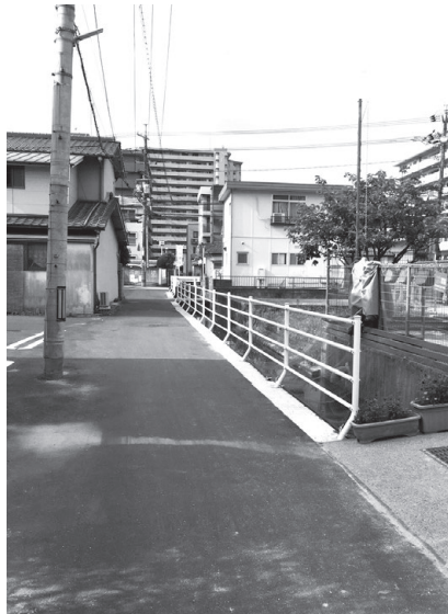
ガードパイプ設置
