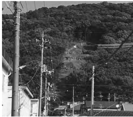
半田山の土砂崩れ
